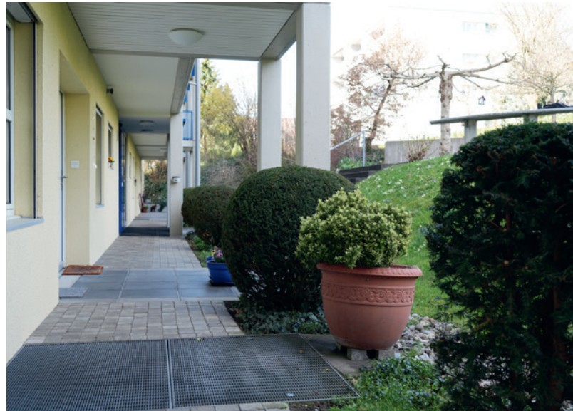
Die Zugehwege beim Sonnentälweg 4 wurden ausgebaut
