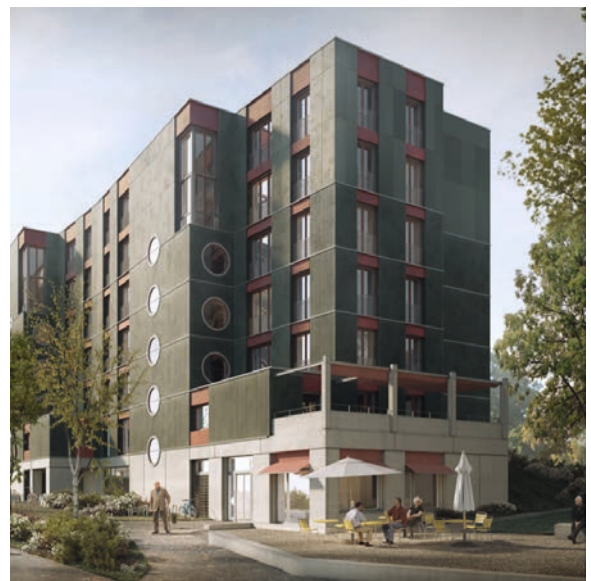
Blick von der Rehbühlstrasse her (Ecke Nord- zu Westfassade)
